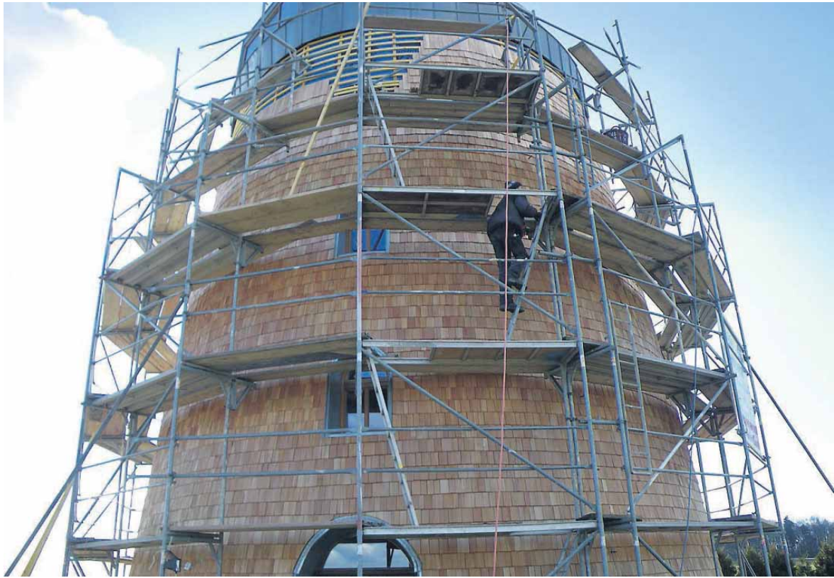
Die Kischlitzer Windmühle in der Kur: Dachdeckerfirma Kirsch verkleidet sie mit Holzschindeln aus Lärchenholz.
